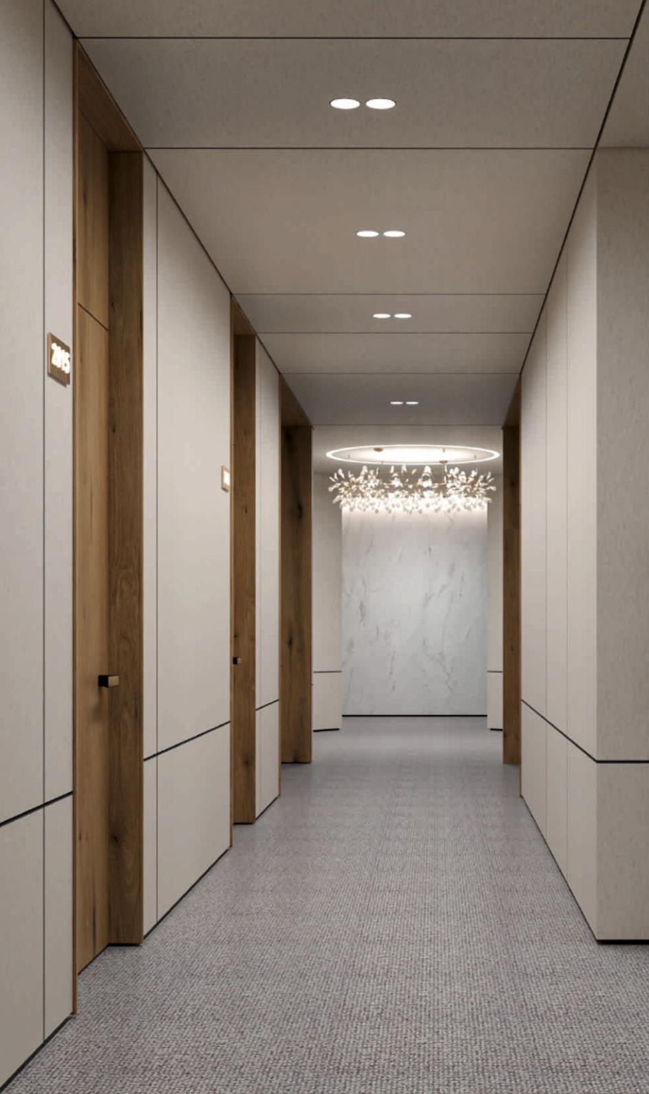
Стык панелей через тенивую планку
